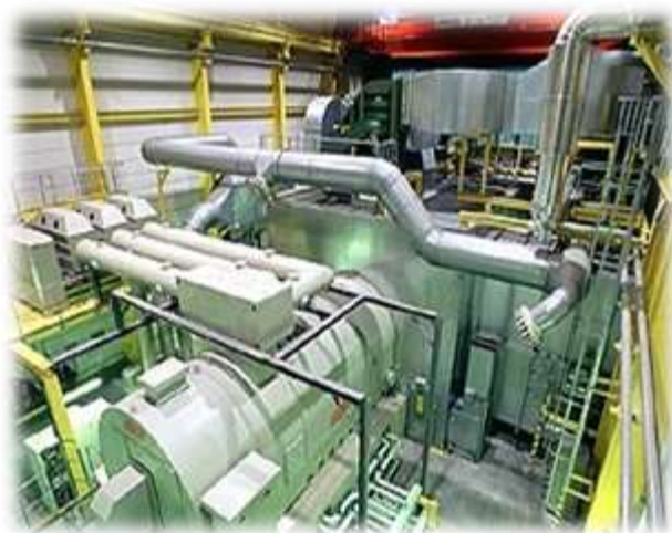
FIAT Melfi Pensotti Caldaie
