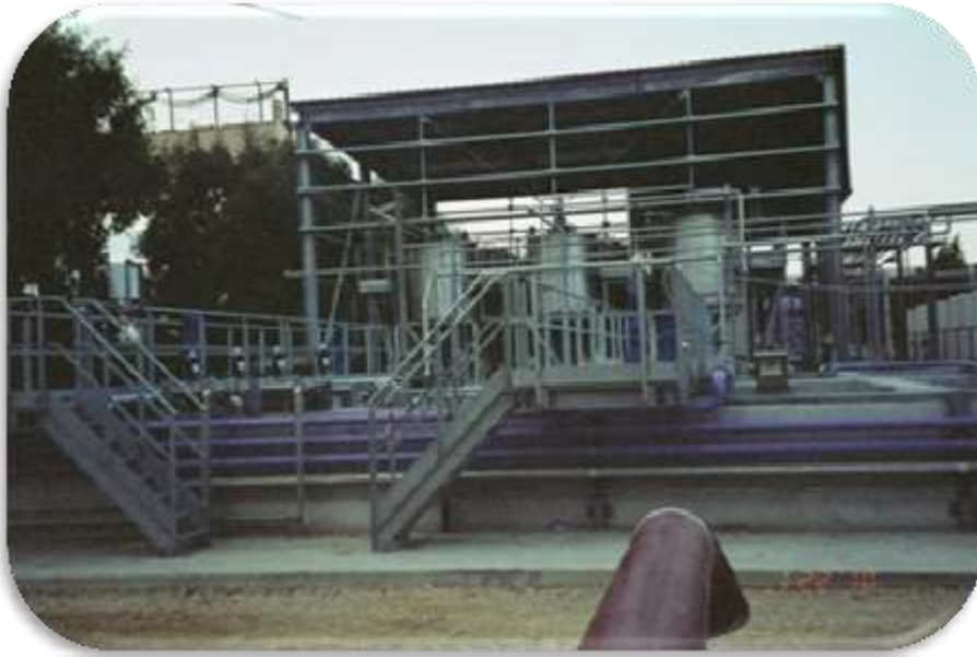
Impianto Trattamento Fanghi: ILVA
